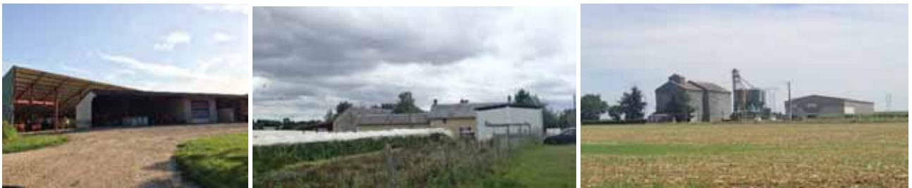
Des constructions agricoles annexes employant des matériaux et structures contemporaines en rupture avec l'architecture ancienne (à gauche Berry-Bouy, au milieu St Michel de Volangis) et des constructions isolées de grande ampleur qui marquent le grand paysage en accompagnant l'évolution de l'activité agricole (à droite Trouy).
