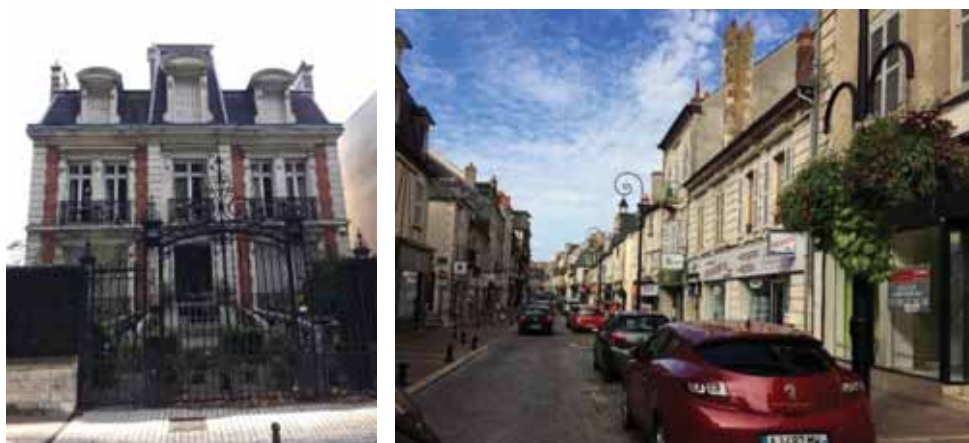
Dans Bourges, des maisons de maître (à gauche), qui interrompent notamment les fronts bâtis composés de maisons de ville et de petits immeubles (à droite)
