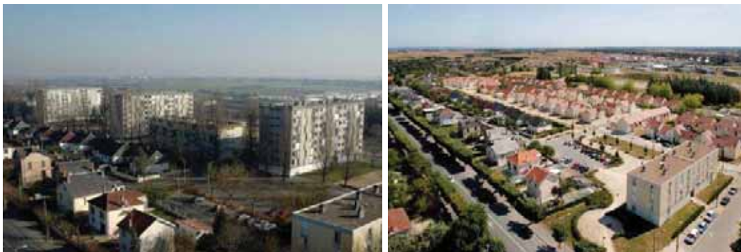
Le quartier Musset Coppée avant et après démolition/reconstruction
