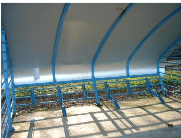
Abri à vélos, gare de Marmagne. A noter que le matériel d'accroche retenu (pince-roues) n'est pas adapté (risque de voilage de la roue avant et de vol du vélo).
