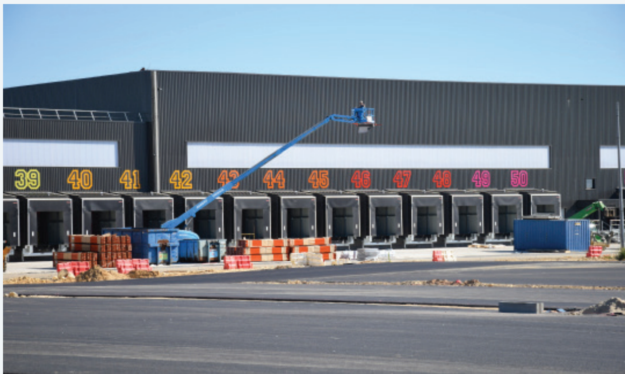
Base logistique Intermarché - Zac de l'Échangeur
