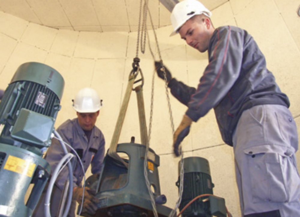
Remplacement d'une pompe à Saint-Doulchard
