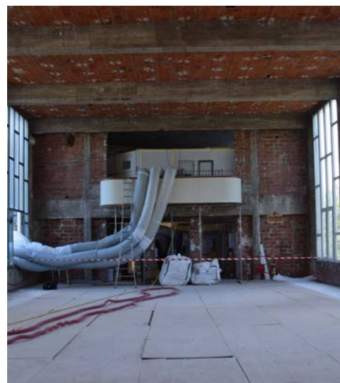
Une opération de désamiantage à été réalisée dans l'ancienne salle Chopin avant sa transformation en salle du conseil communautaire et de conférences
