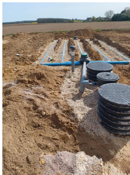
Figure 29 : Exemple de contrôle de microstation suivi d'un épandage
