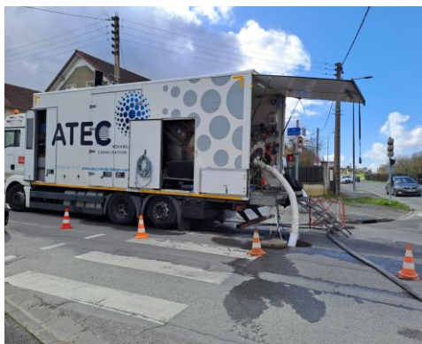
Figure 10 : Chantier de remisage de canalisation par chemisage intérieur à Bourges
