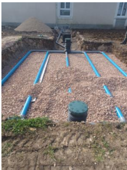
Figure 28 : Exemple de contrôle de fosse toutes eaux + lit filtrant non drainé à flux vertical avant remblaiement
