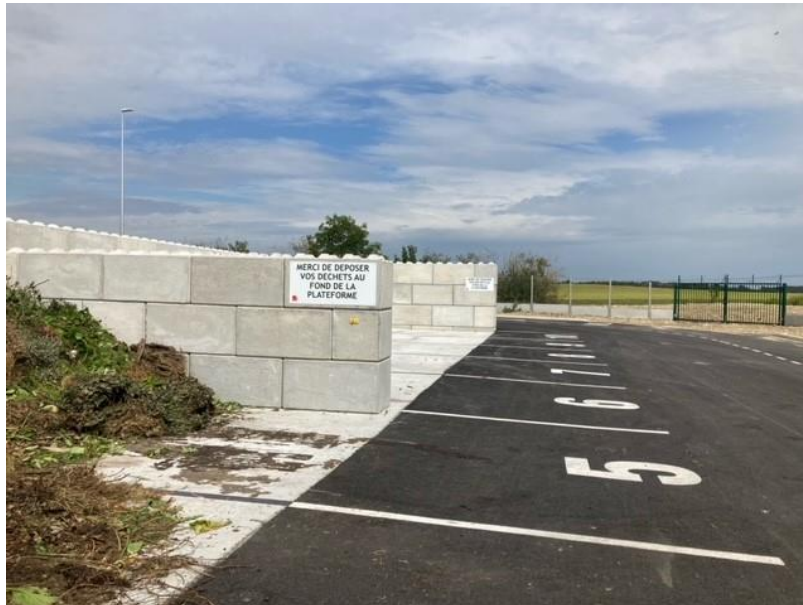
Saint-Doulchard : Plateforme déchets verts avec emplacement des véhicules pour optimiser le stationnement
