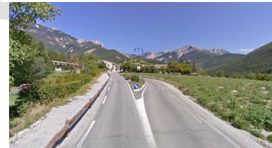
Ilot central en entrée de village
