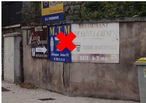
Murs de clôtures
