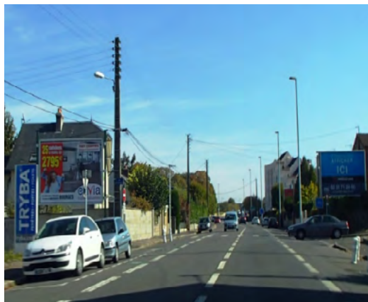
Axe pavillonnaire : avenue François Mitterrand - Bourges
