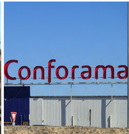
Une enseigne en toiture
