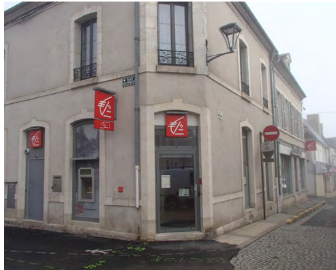
Respect des ouvertures du bâtiment (Mehun-sur-Yèvre)
