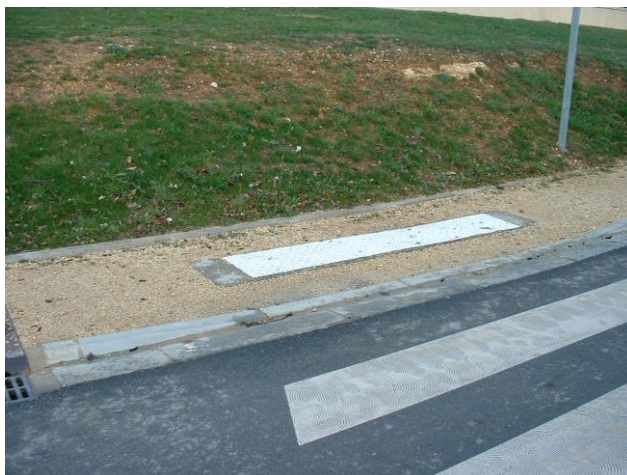
Abaissé (non conforme) et dalle podotactile à Morthomiers
