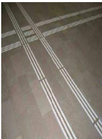
Bandes de guidage au sol pour les aveugles et les malvoyants (photo SNCF)
