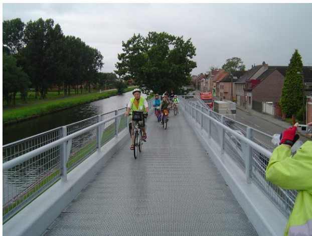
Rampe d'accès à une passerelle franchissant un canal en Seine-et-Marne (photo : avon.fubicy.org )
