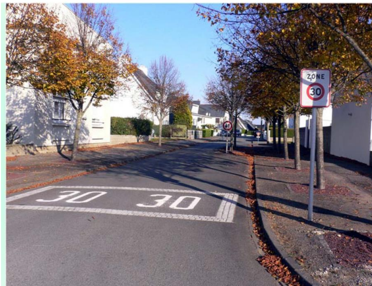
Zone 30 peu onéreuse mais efficace à Lorient, matérialisée par des pavés en résine et, au 2 nd plan, par un rétrécissement de chaussée imposant la circulation alternée des véhicules (photo : Ville de Lorient)
