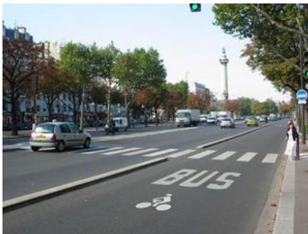
Couloir bus-vélos à Paris
