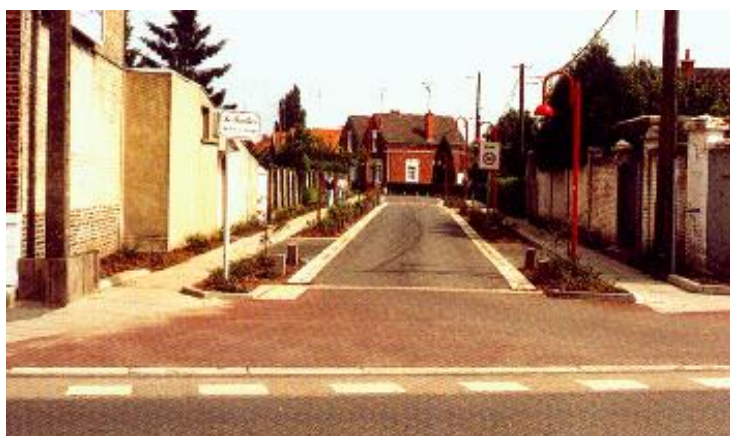
Trottoir traversant, à Bruay/Escaut (62). Le trottoir traversant inverse la logique habituelle : les piétons restent au même niveau, tandis que les véhicules subissent une dénivellation (photo : CERTU).
