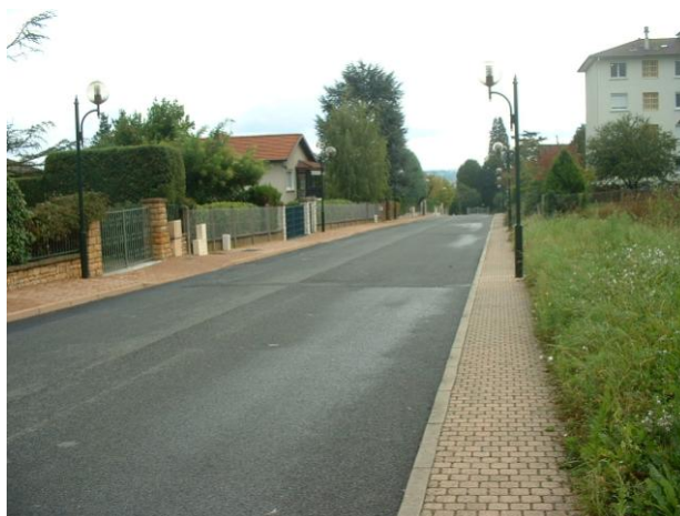
Lampadaires sur le bord intérieur du trottoir (Gleizé, Rhône)
