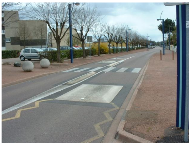
Coussin à Mably (Loire). Les coussins permettent aux bus et aux vélos d'éviter la dénivellation.
