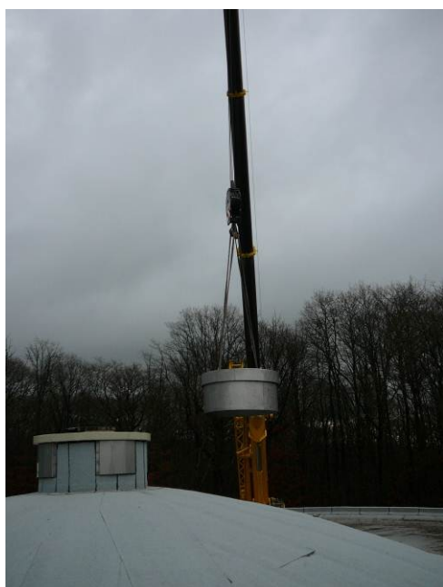
Figure 54 : Travaux de sécurisation des lanterneaux du réservoir de Gron
