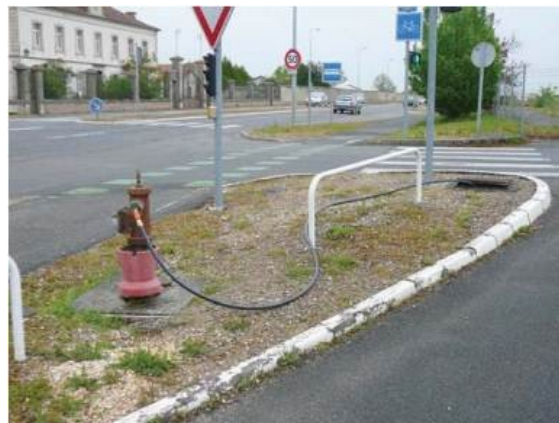
Figure 39 : Prise d'eau frauduleuse
