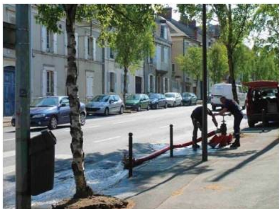
Figure 38 : Pesée d'un hydrant par le service départemental d'incendie et de secours
