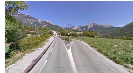
Ilot central en entrée de village
