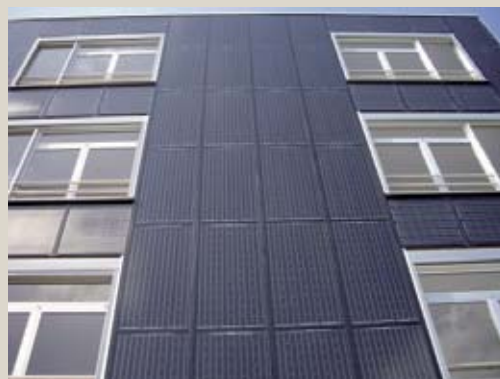
Façade recouverte de panneaux photovoltaïques
